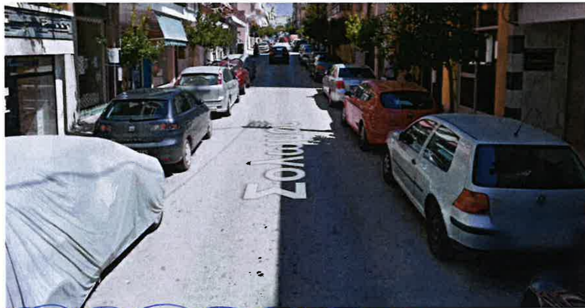
Εικόνα 8: Υφιστάμενη Κατάσταση Οδού Σολωμού (Πηγή: Google Maps)
