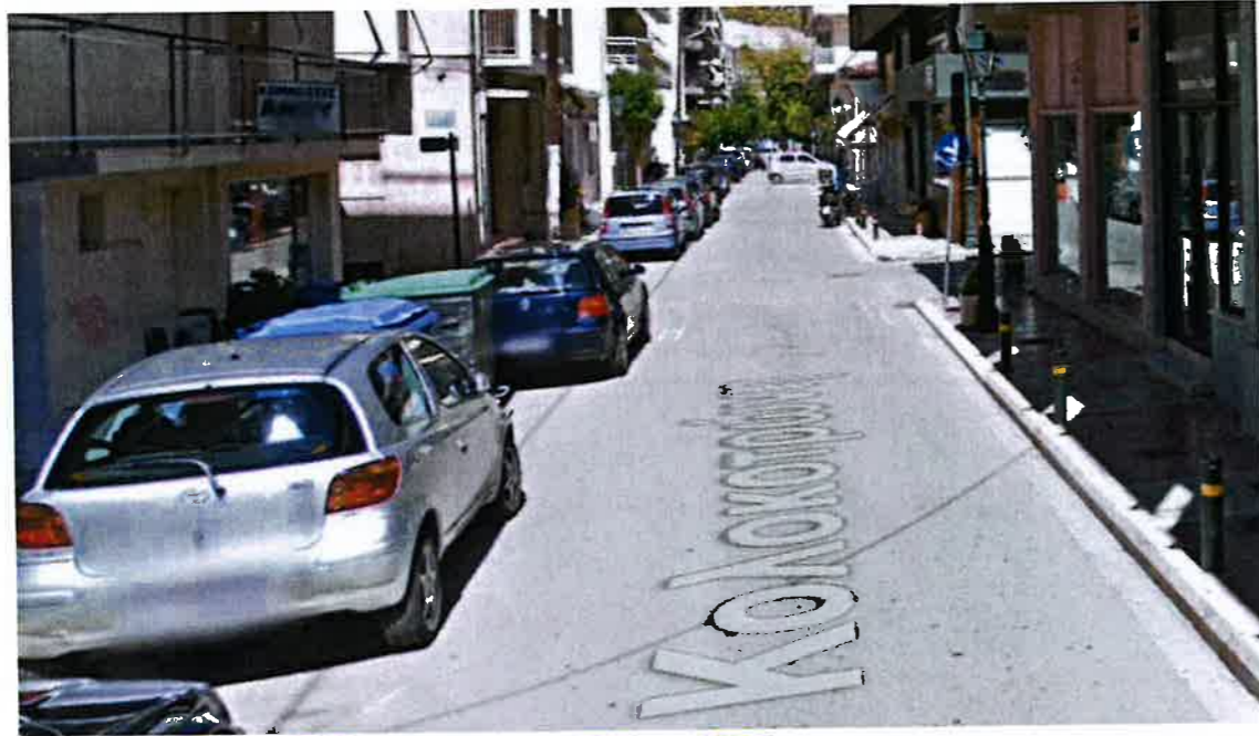
Εικόνα 6: Υφιστάμενη Κατάσταση οδού Κολοκοτρώνη (Πηγή: Google Maps)
